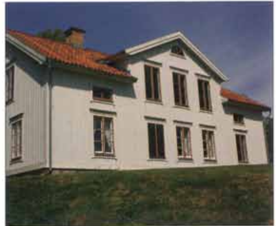
Mangårdsbyggnaden vid Färsna gård, som byggdes 1887, är nu rustad för stiftelsens verksamhet.
