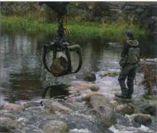
Restaurering av strömkoncentrator i Norrtäljeån vid Stadshotellet.
