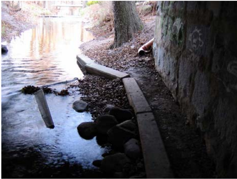
Figur 16. Anlagd utterpassage med konstgjord strand vid Rimbo, Norrtälje. Foto: Erik Hammar.
