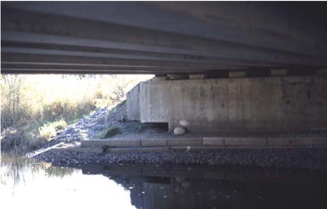
Figur 17. Anlagd utterpassage med konstgjord strand vid Skebobruk, Norrtälje. Observera den utlagda "markeringsstenen" med utterspillning. Foto: Gunnar Hammar.
