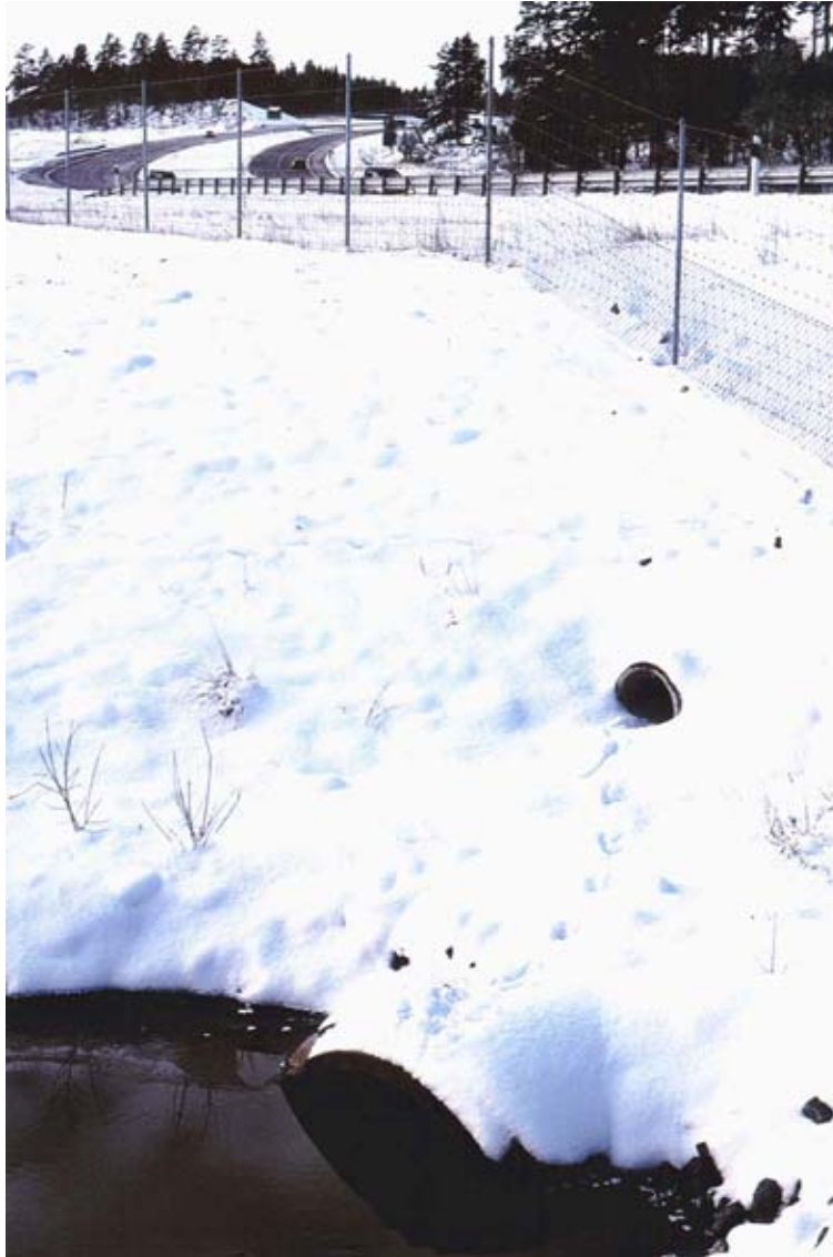
Figur 13. Anlagd utterpassage med trumma och viltstängsel under E18 vid Ledinge, Norrtälje. Denna vattenförande trumma är vid vissa tider helt vattenfylld. Bilden visar även spår efter en utter som har gått upp ur ån för att först avsätta en markering på trumman och sedan gå in i uttertrumman. Foto: Roine Karlsson
