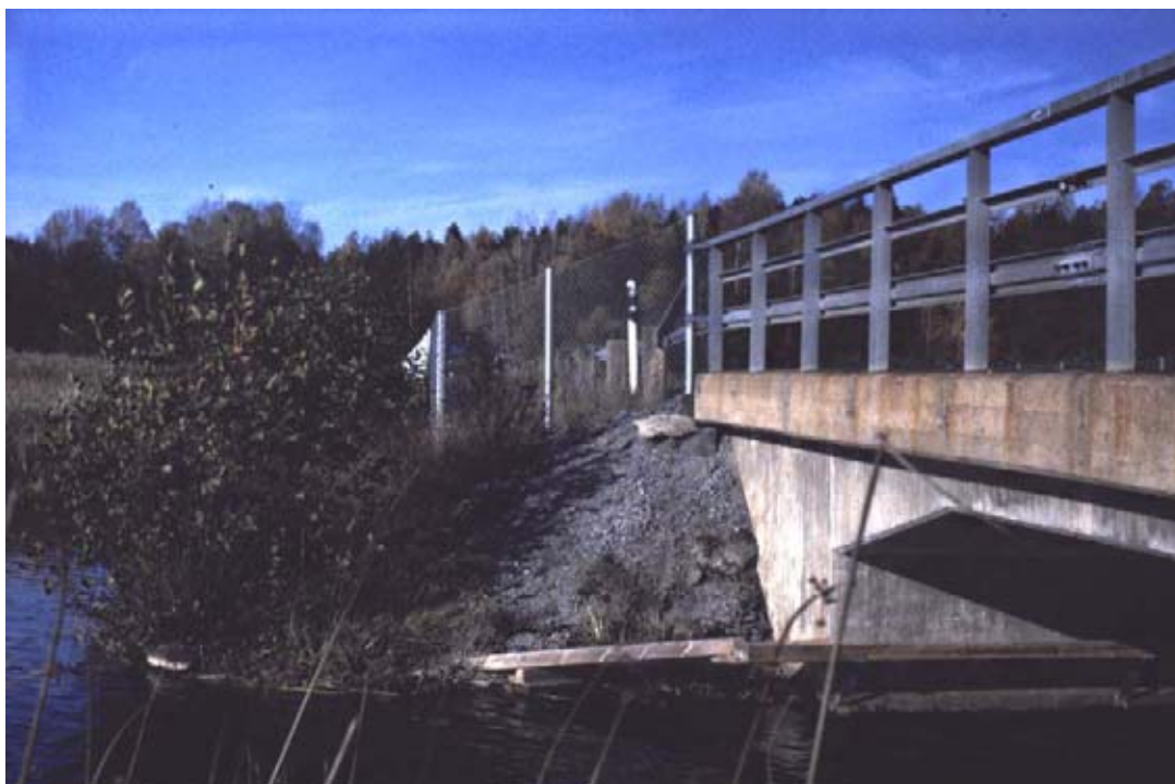
Figur 19. Anlagd utterpassage med trähylla och styrande viltstängsel vid bron över sjön Närdingen, Norrtälje. Foto: Gunnar Hammar
