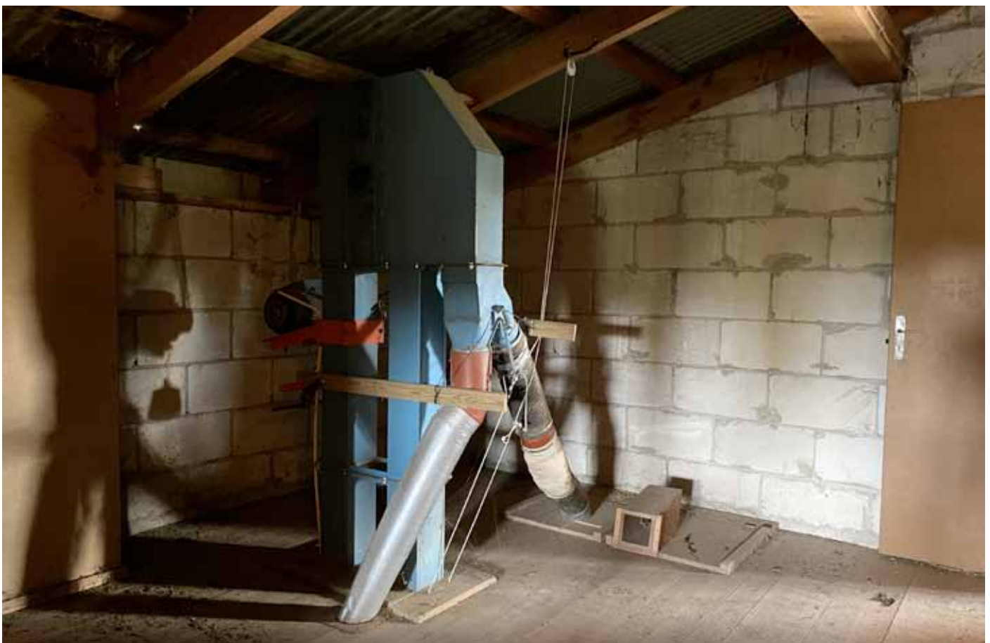
Elevator för transport från rens
